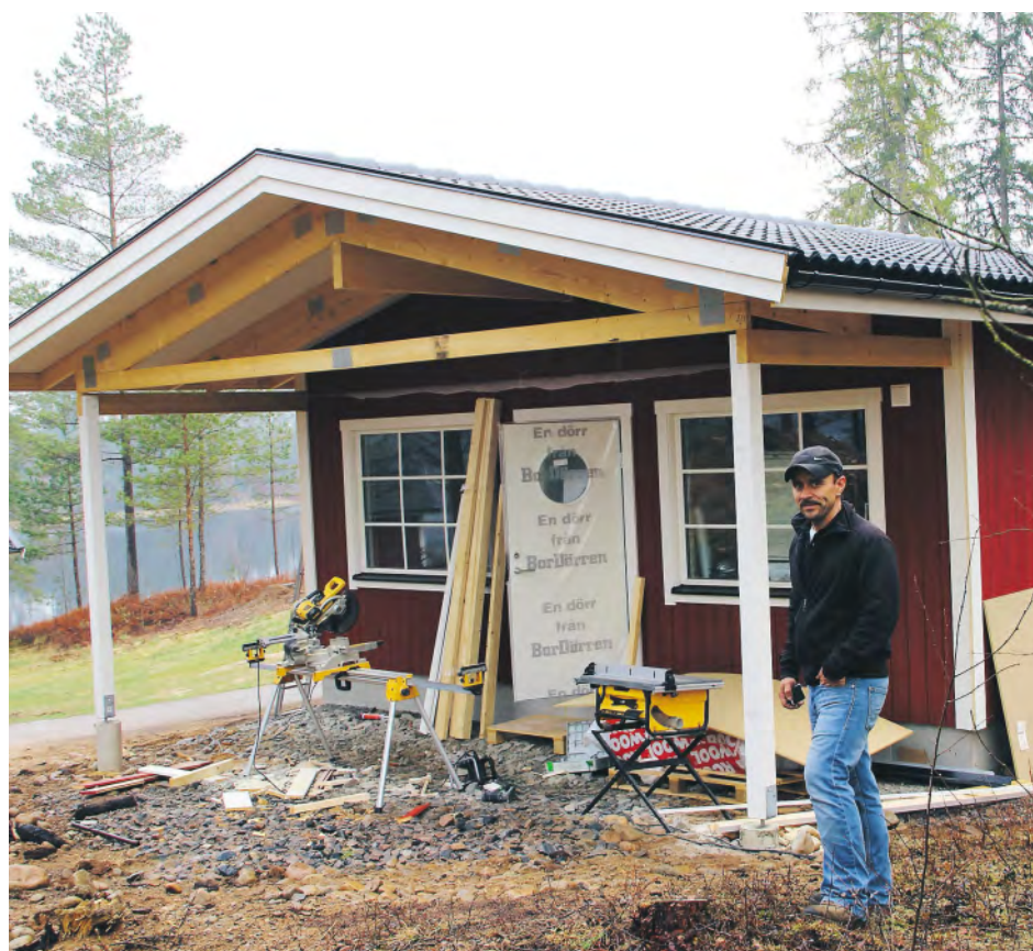
BYGGER NYTT. Pelle Andersson visar en av de nya stugorna som byggs på Överlida Camping.
