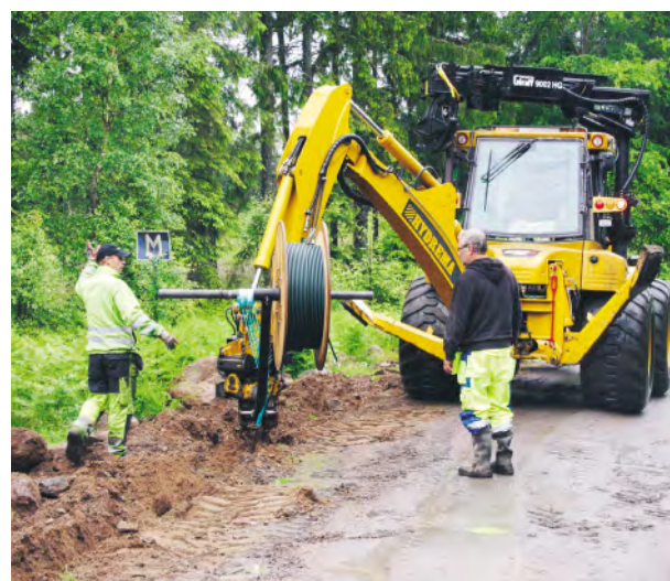
PIONJÄRER. Södra Kinds fiber var först av de fem föreningarna att komma igång. Grävningarna startade förra året, i Mårdaklev.
